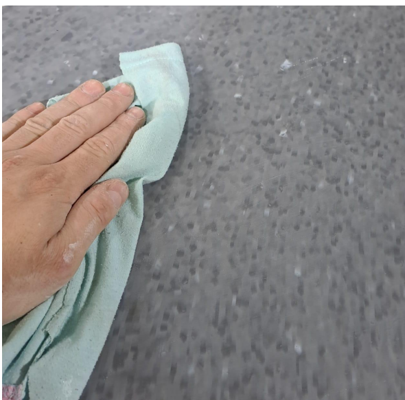
Paso 1: limpiar el área después del lijado.
