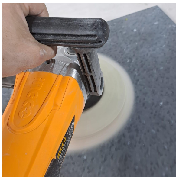
Paso 4: comenzar a pulir con precaución siguiendo un ritmo y una misma dirección.
